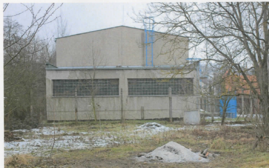
Budova teplárny za severní hranicí pozemku tvoří výraznou dominantu celého území.
