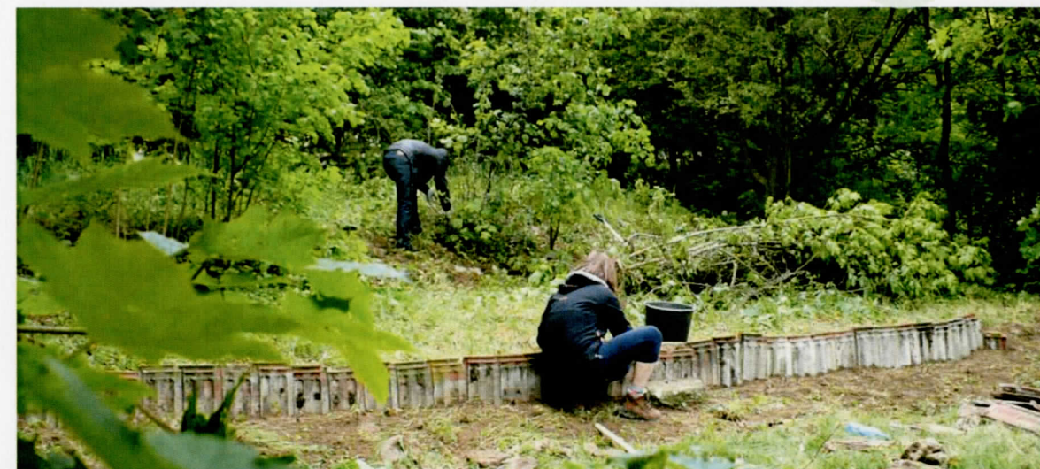
Budování a oprava teras
