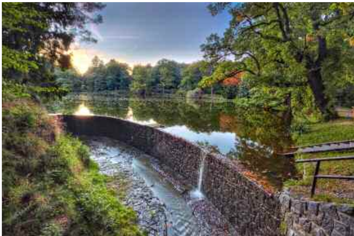
V případě malého odtoku vody působí bezpečnostní přeliv až idylicky (Průhonice – Labeška)
