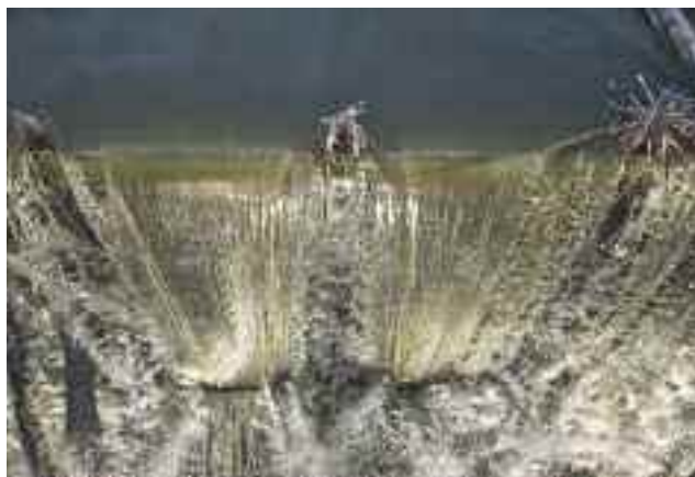
Ukázka regulace výšky hladiny pomocí přepadu (přepad na žehuňském rybníku)
